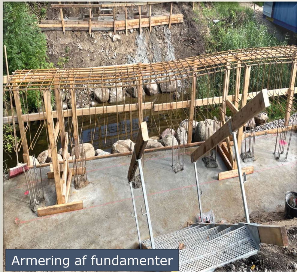
Fundamenter med skråninger i store marksten
