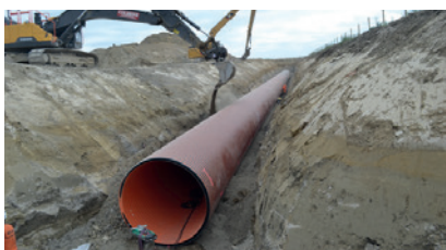
GRAVITATIONSLEDNING TIL SPILDE- OG REGNVAND
