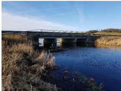
Bro nr. 4943 – Løgstørvej
