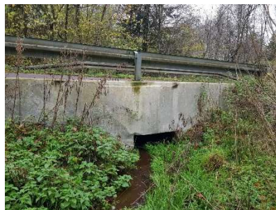
Bro nr. 19595 – Åhusevej
