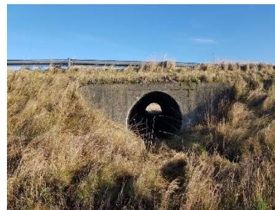
Bro nr. 11700 – Løgstørvej
