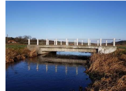
Bro nr. 4972 – Boruphedevej
