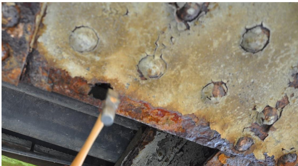
Figur 2: Korrosion i bunden af hoveddrager.
