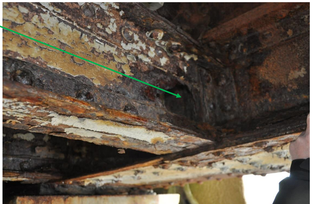
Figur 1: Korrosion på tværdrager.
