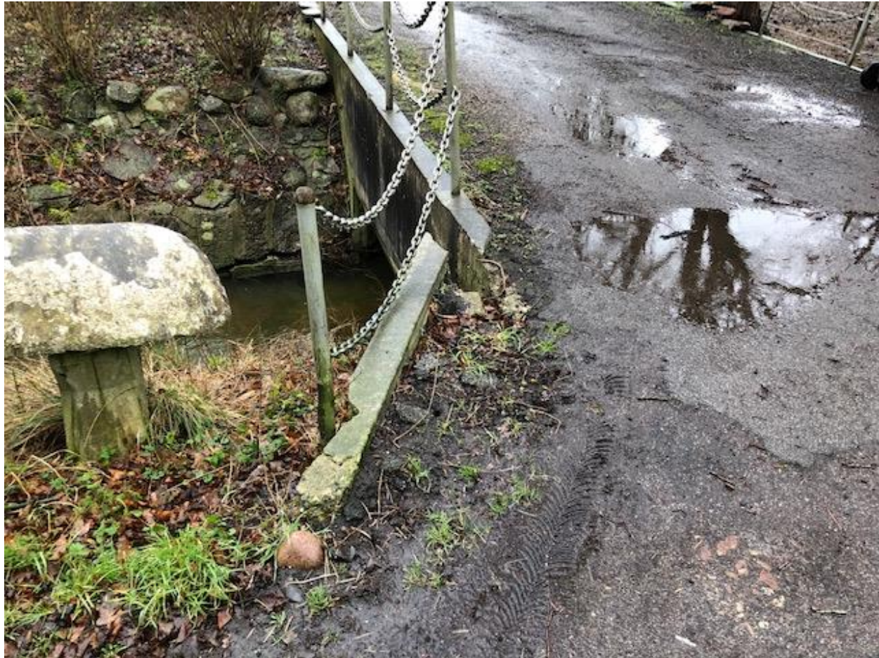
Bro over det offentlige vandløb.
